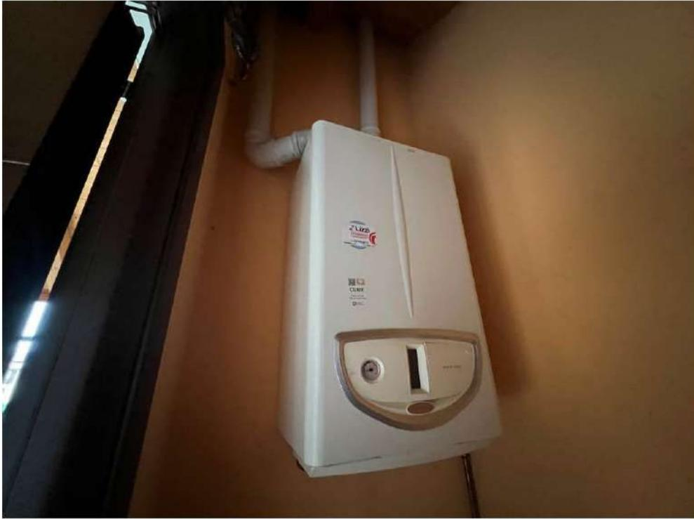
Fotografia n. 20 – Particolare della caldaia a gas presente nel locale ripostiglio
